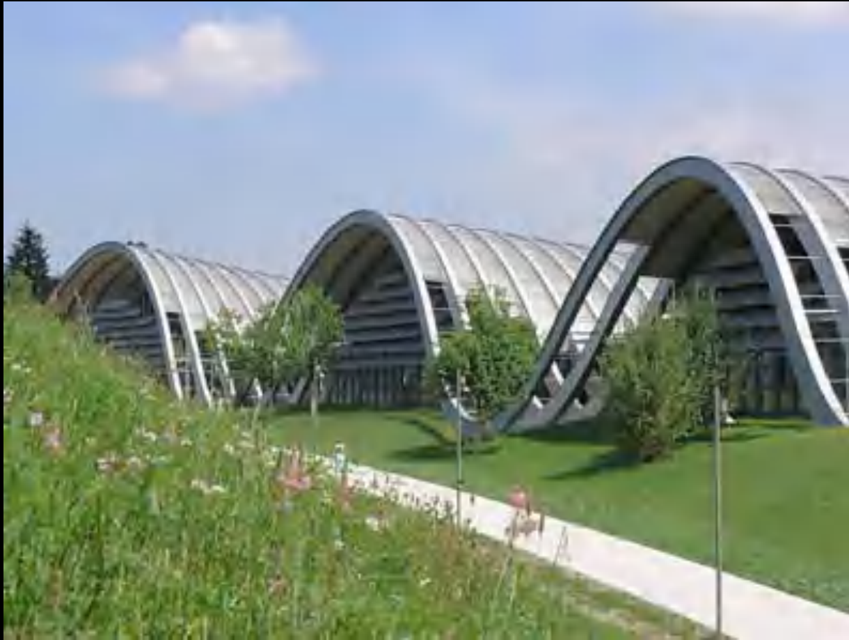
Centro Paul Klee de Berna, del arquitecto Renzo Piano.
